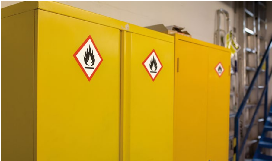
Gefahrstofflagerschränke in Fluchtwegbereichen müssen unbedingt vermieden werden.
